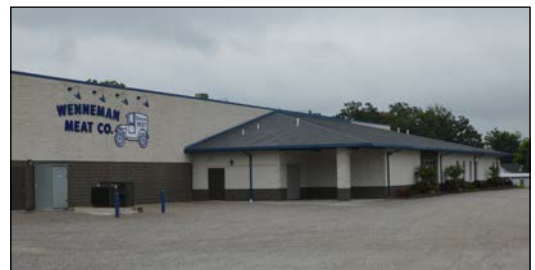
Wennemans erweiterter Produktionsbereich und Laden, fertiggestellt Ende 2011.
